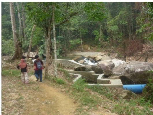
Mini hydro power station
